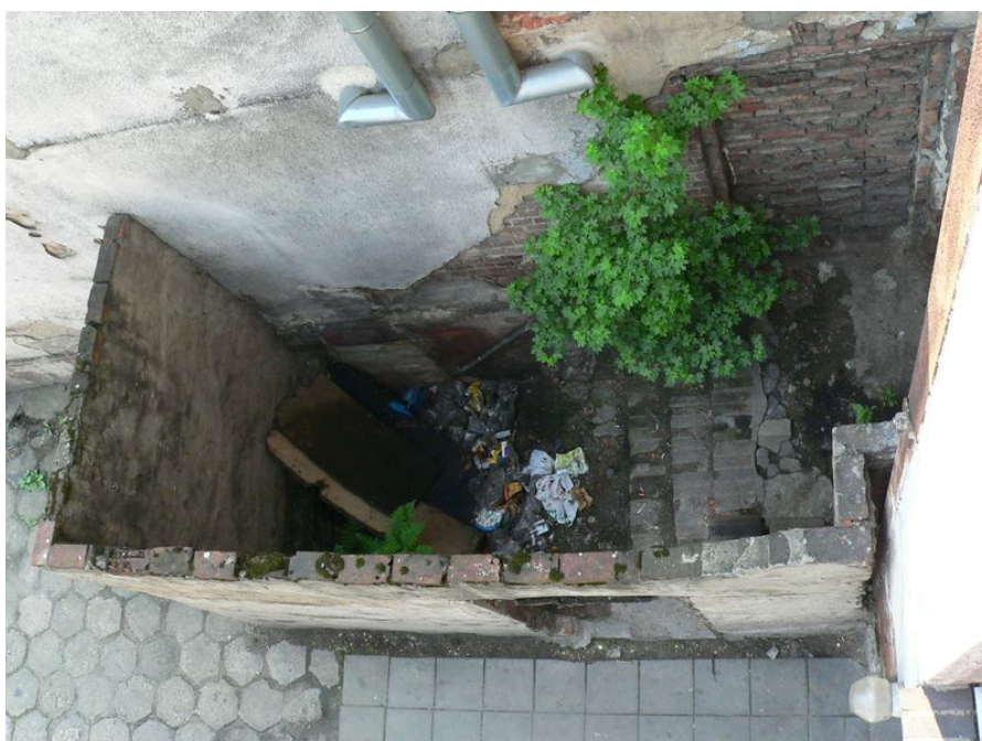
Zdj. 6 Ściany przybudówki o gr. ½ cegły. Wewnątrz widoczne schody oraz zamurowane przejście do oficyny. Brak zadaszenia, roślinność oraz śmieci destruktywnie wpływają na ściany części mieszkalnej budynku oficyny.
