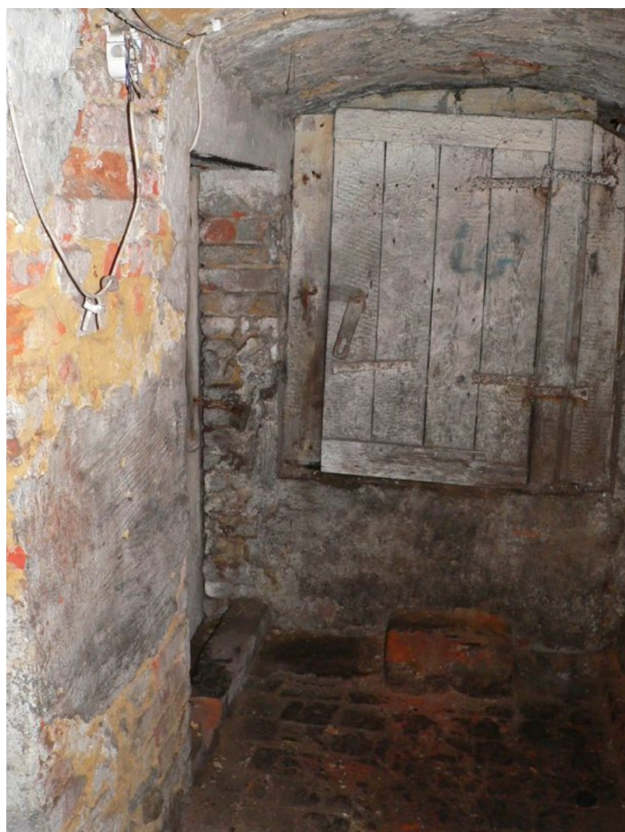
Zdj. 9 Zawilgocone tynki ścian i mokra cegła posadzki.
